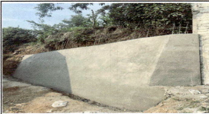
Foto 3: Reparación de muro de contención EORM del Paraje El Pito, Aldea Subchal
