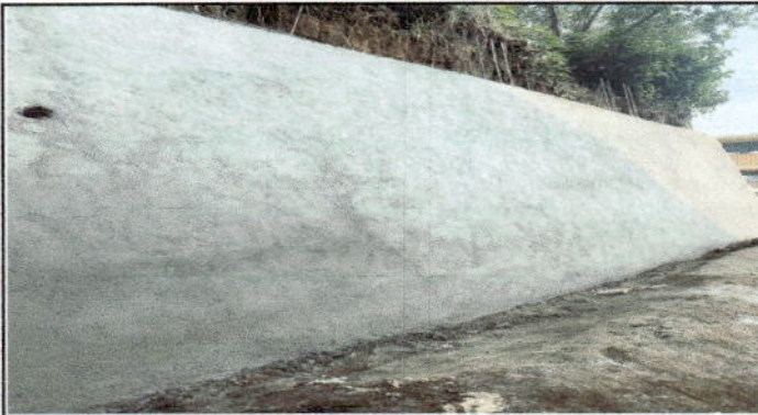
Foto 1: Reparación de muro de contención EORM del Paraje El Pito, Aldea Subchal.
