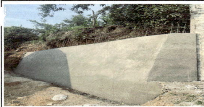
Foto 5: Reparación de muro de contención EORM del Paraje El Pito, Aldea Subchal.
